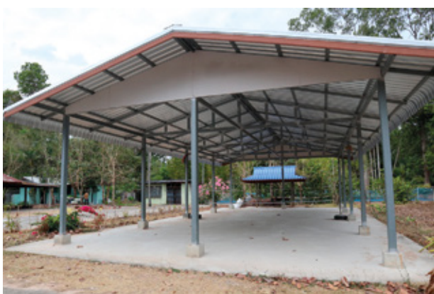
โรงอาหารและพื้นที่ทำกิจกรรมนักเรียนขนาดงบประมาณ ทำต่อให้เสร็จสมบูรณ์
